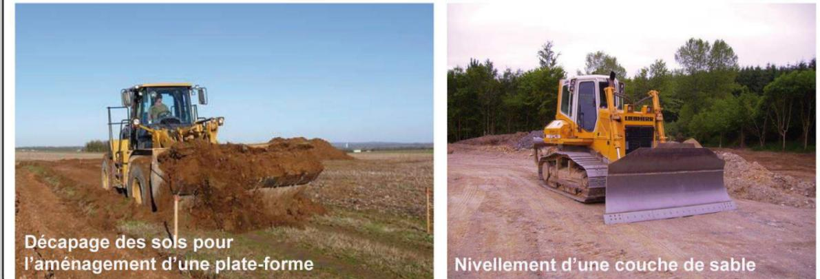
Photographie 48 : Exemples d'engins de travaux de VRD
