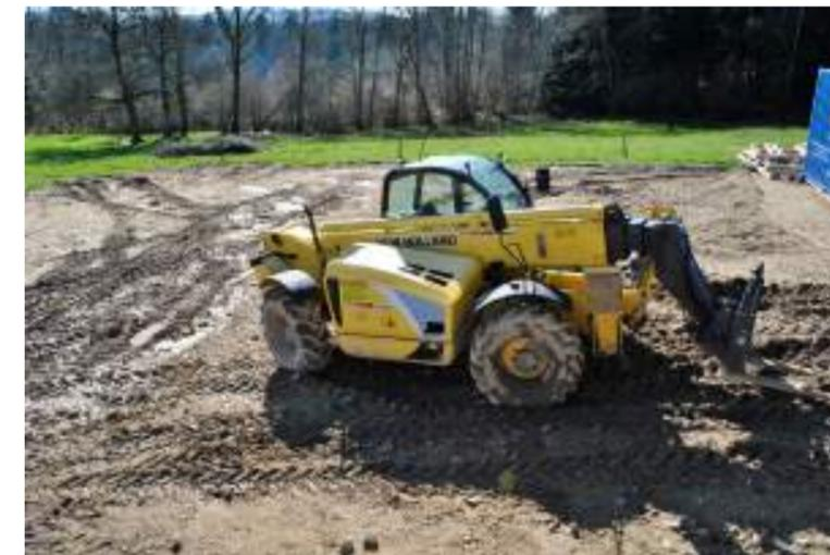
Photographie 52 : Exemple de tassement et d'ornières créés par les engins de chantier
