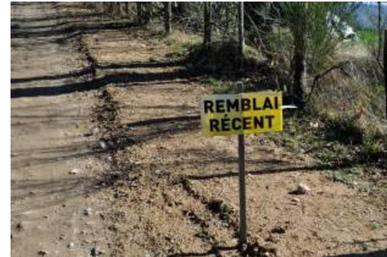
Photographie 53 : Exemple de remblai des tranchées électriques le long d'une piste (Source : ENCIS Environnement)
