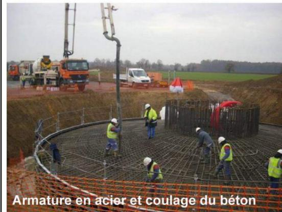
Armature en acier et coulage du béton
