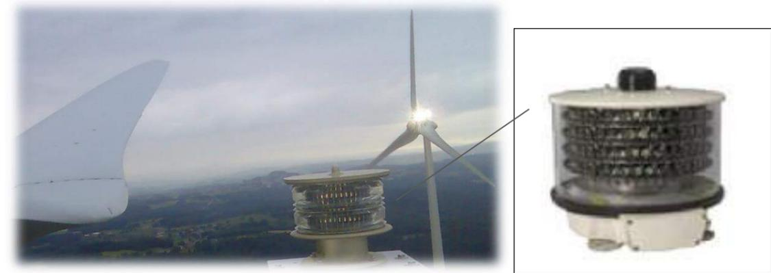
Figure 39 : Balisage d'une éolienne
