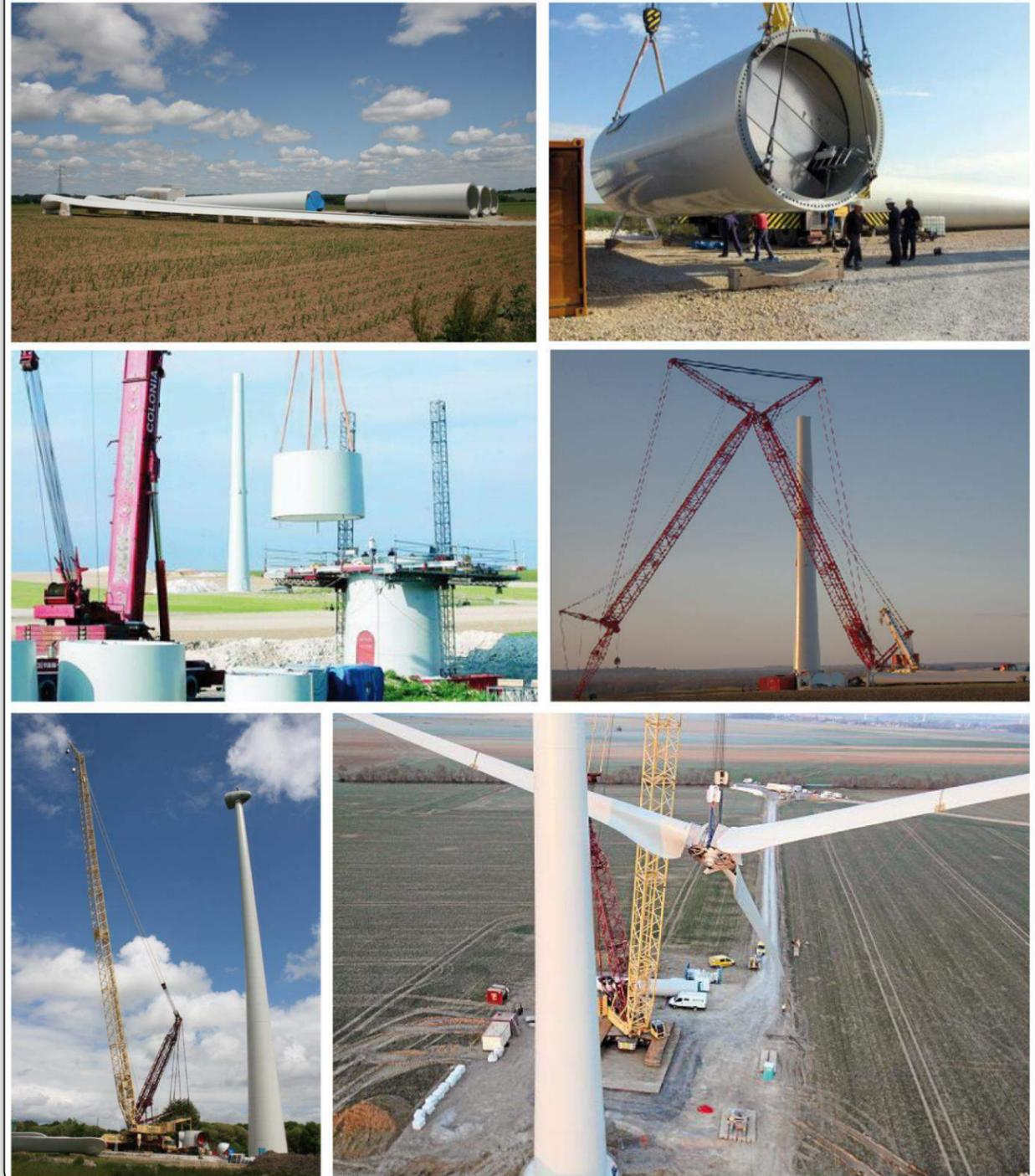
Photographie 51 : Phases d'assemblage d'une éolienne
